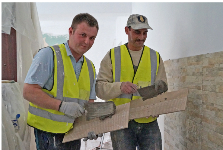
Schritt für Schritt kamen auch die Erneuerungsarbeiten des Tageszentrums im Jahr 2015 voran
